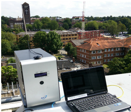
図4・7 LTE基地局の設置状況
