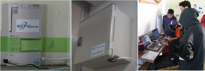
図 5・6 避難所に設置されたコグニティブ無線ルータ 簡易設置 (左)、防水設置 (中) とそれを用いた情報収集の様子 (右)
