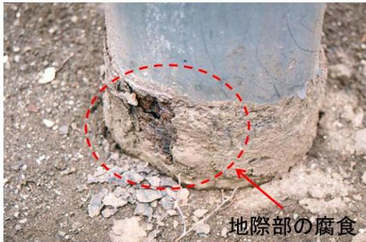
**図 9・19** 鋼管柱の地際部腐食の事例
