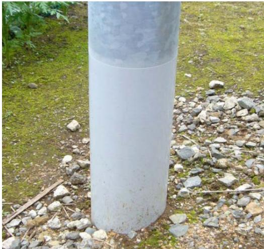
**図 9・20** 鋼管柱の地際部腐食の対策（熱可塑性ポリエステル樹脂コーティング）
