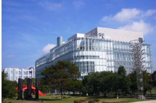
図4・1 フジテレビジョン湾岸スタジオ外観
