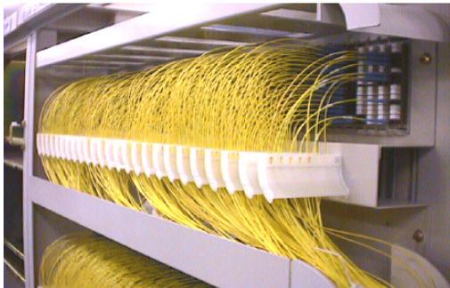
図 9・3 4000 心 FTM (MU 型簡易レセプタクルを用いた 1 架 4000 心を収容する光ファイバ終端架)
