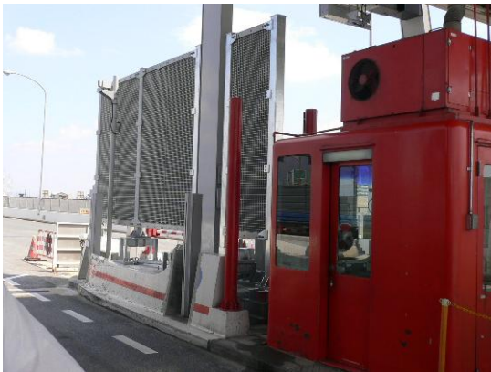
図 5・21 通気性を考慮した格子型電波吸収体
