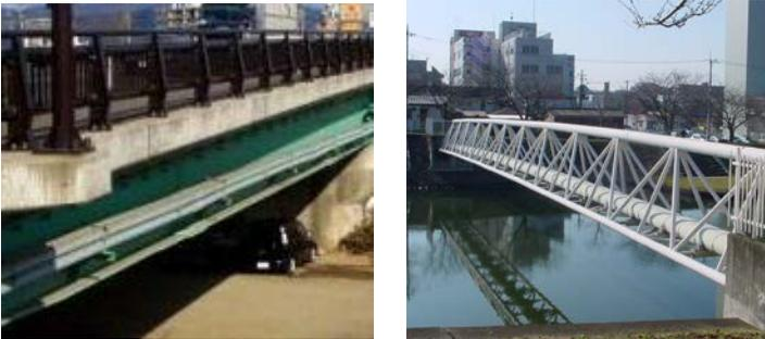
図 8・6 左：橋梁添架管路，右：専用橋
