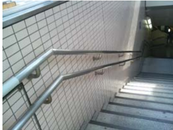
図 7・4 高さの異なる手すり (写真: 著者撮影)
